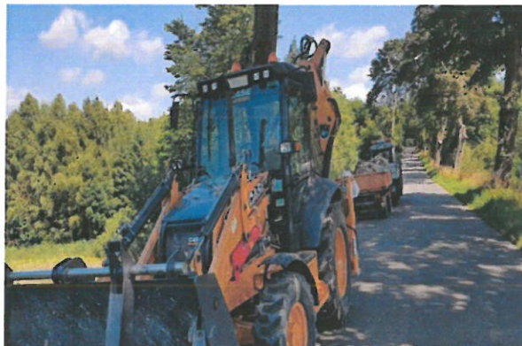
Remonter – maszyna do likwidacji ubytków nawierzchni i spękań
