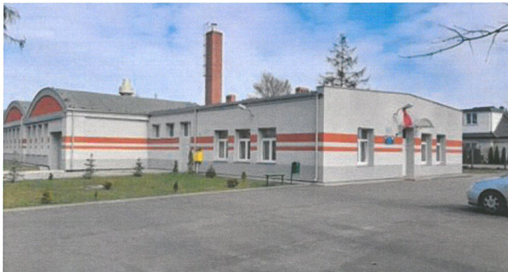
Siedziba Centrum Kształcenia Praktycznego oraz Internatu ZSP w Białogardzie po termomodernizacji
