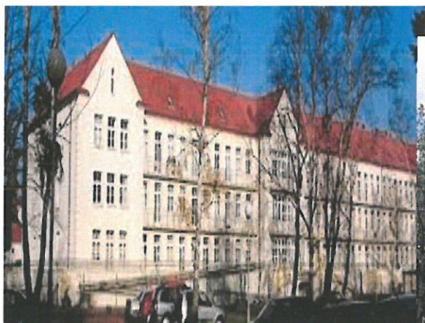
Budynki Szpitala Powiatowego w Białogardzie
