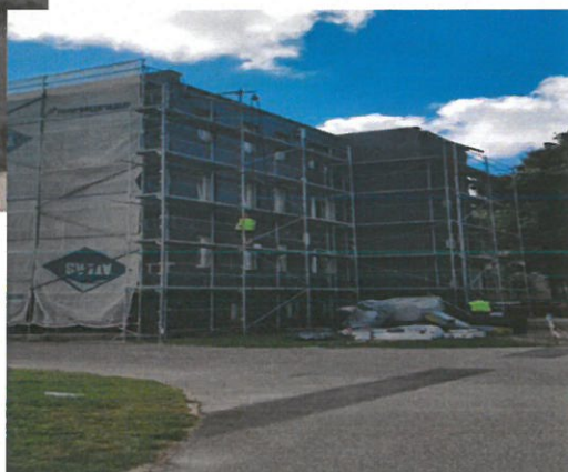
Termomodernizacja budynku Centrum Wspierania Rodziny „Dom pod Świerkiem” - rok 2018
