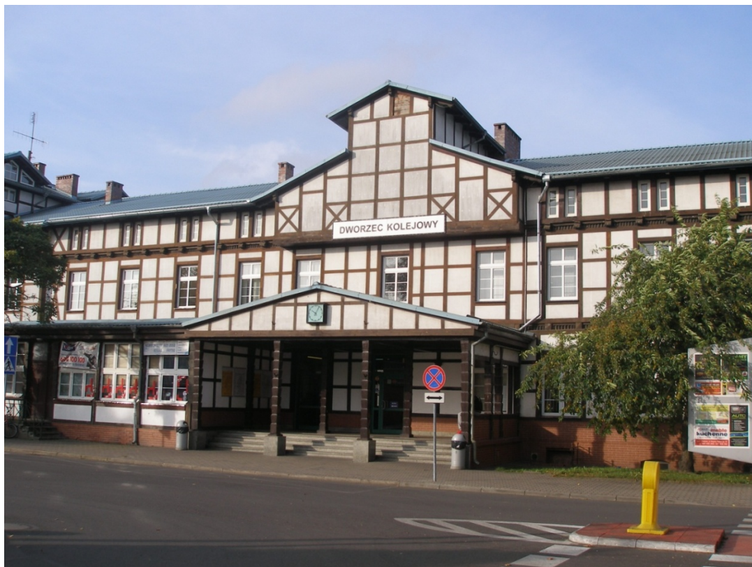
Rys. 10. Budynek dworca PKP w Białogardzie
