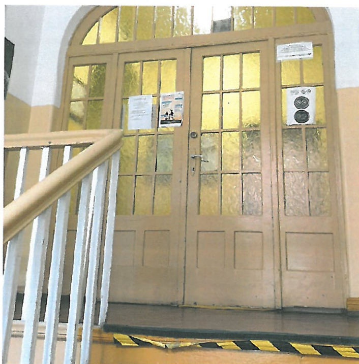
Fot. 2. Widok drzwi wewnętrznych pomiędzy pomieszczeniem komunikacji, a klatką schodową przewidzianych do renowacji. Drzwi zaleca się zdemontować i odrestaurować w specjalistycznym zakładzie stolarskim z zachowaniem istniejącego układu.
