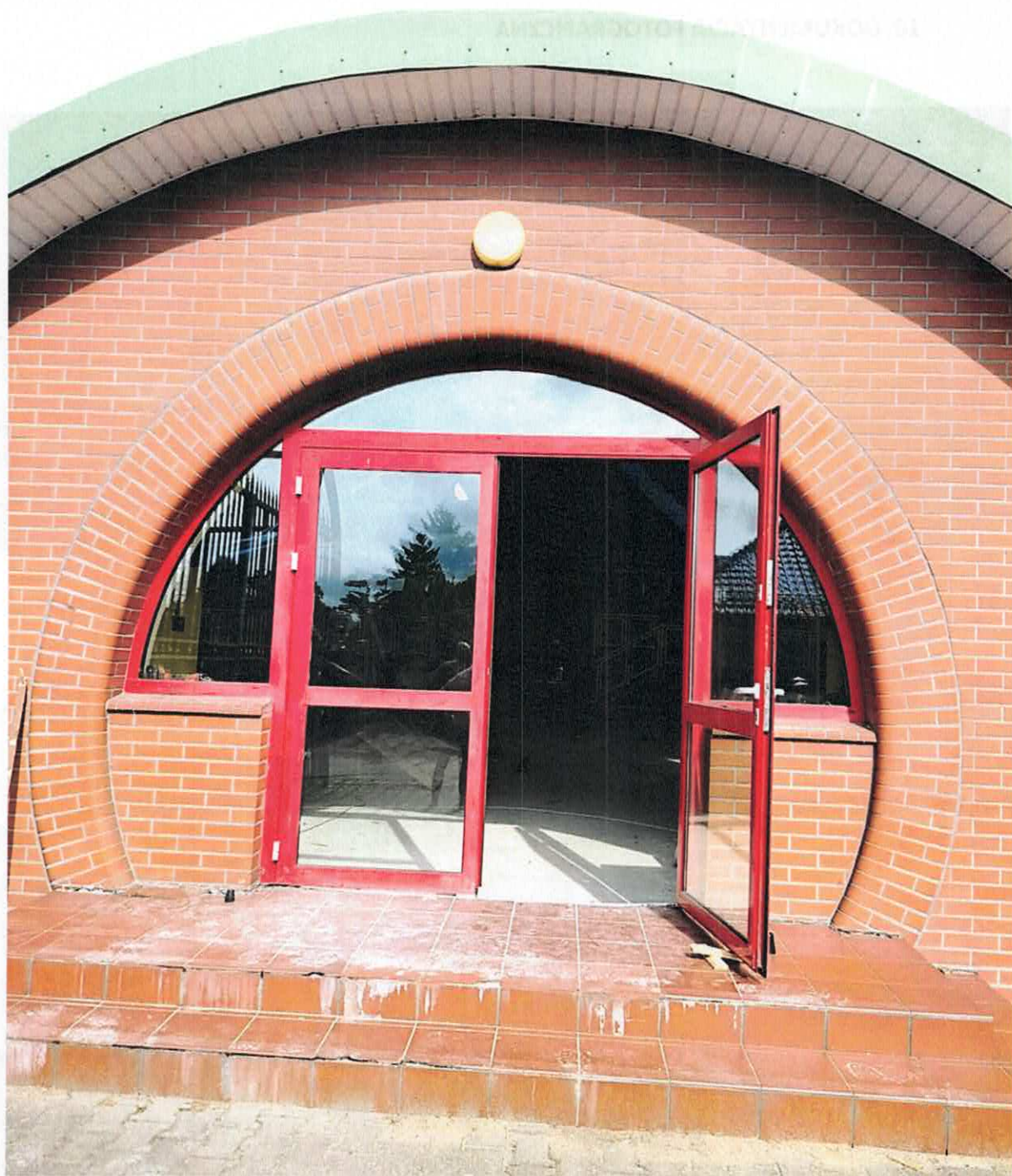
Rys. 5. Widok drzwi zewnętrznych i schodów terenowych przeznaczonych do rozbiórki i powiększenia otworu w celu umożliwienia transportu materiału, maszyn i sprzętu.
