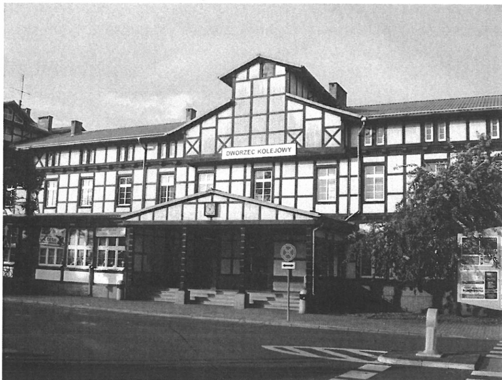
Rys. 10. Budynek dworca PKP w Białogardzie
