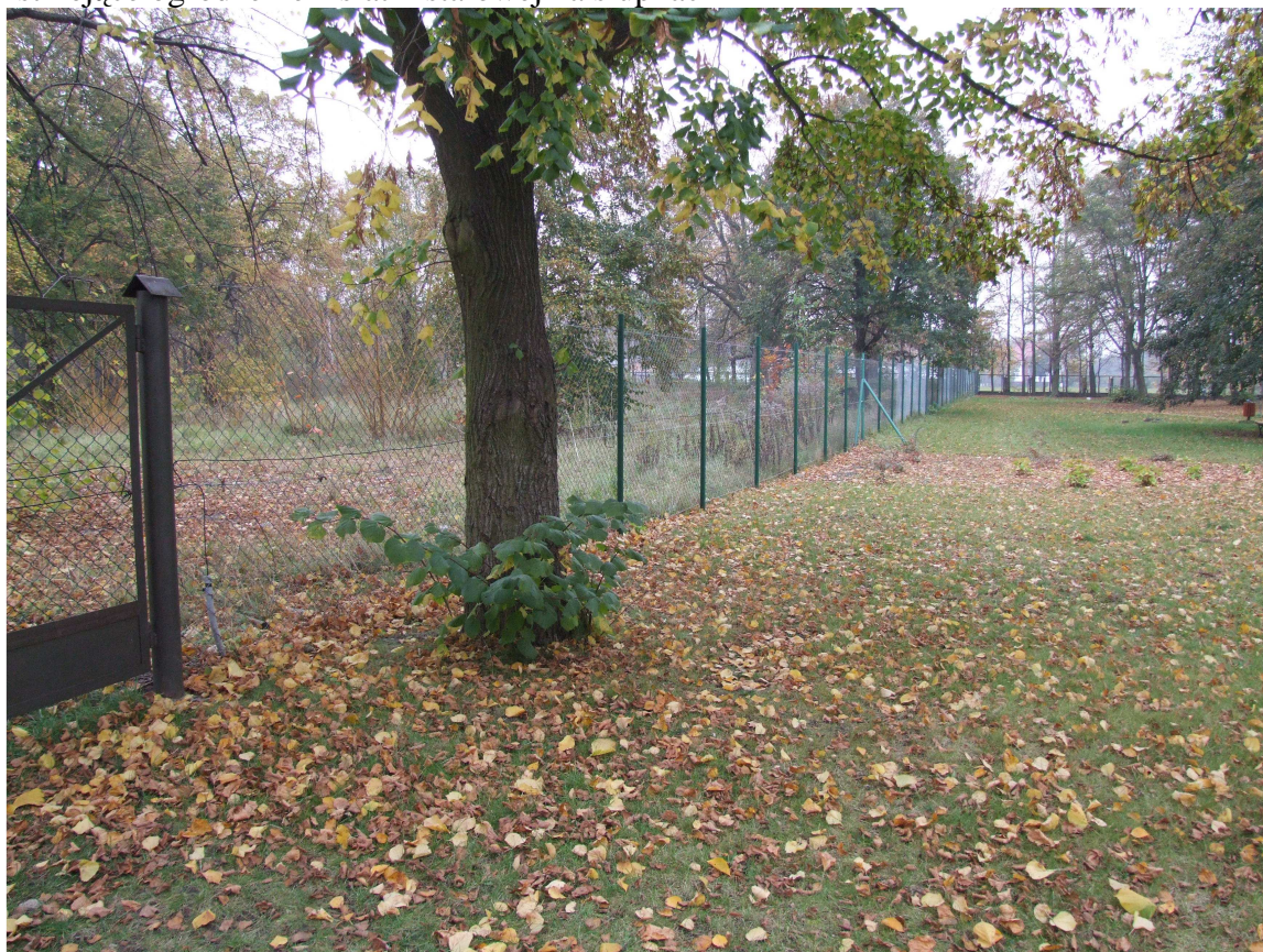
Istniejące ogrodzenie z siatki stalowej na słupkach
