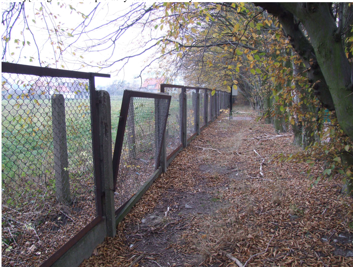
Istniejące ogrodzenie z prefabrykatów betonowych
