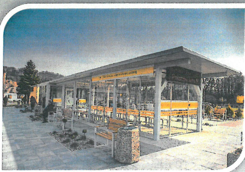
Fotografia 9. Centrum przesiadkowe w Polanowie
