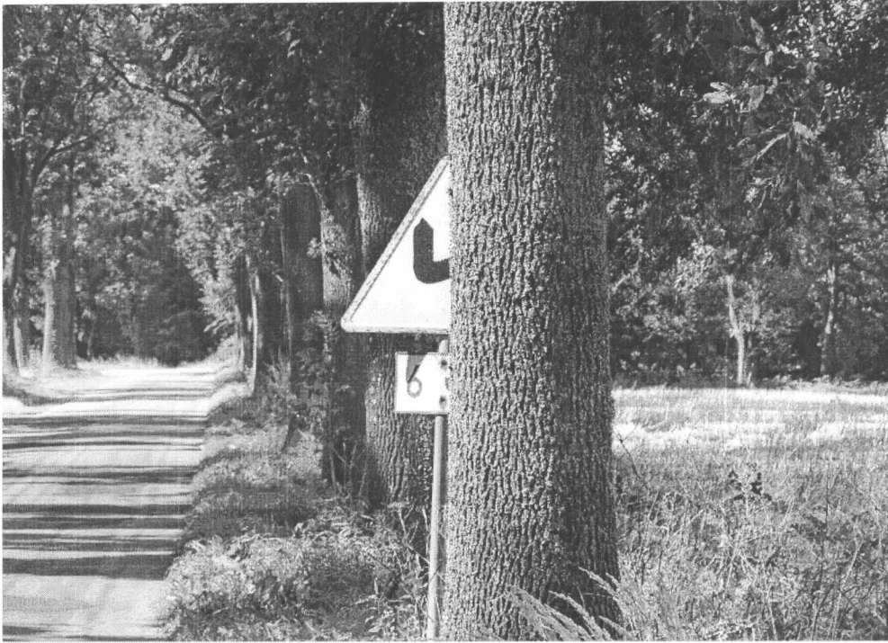
1165 Z na Czarnowęsy – znaki: A-4 i T-4 – za nisko osadzone i niewidoczne z powodu drzew w koronie drogi,
